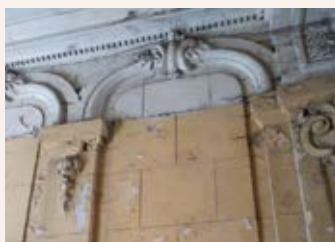
Архитектурни детайли от вътрешната страна на входа на сградата на Москович. Фотограф: Иванка Гезенко
